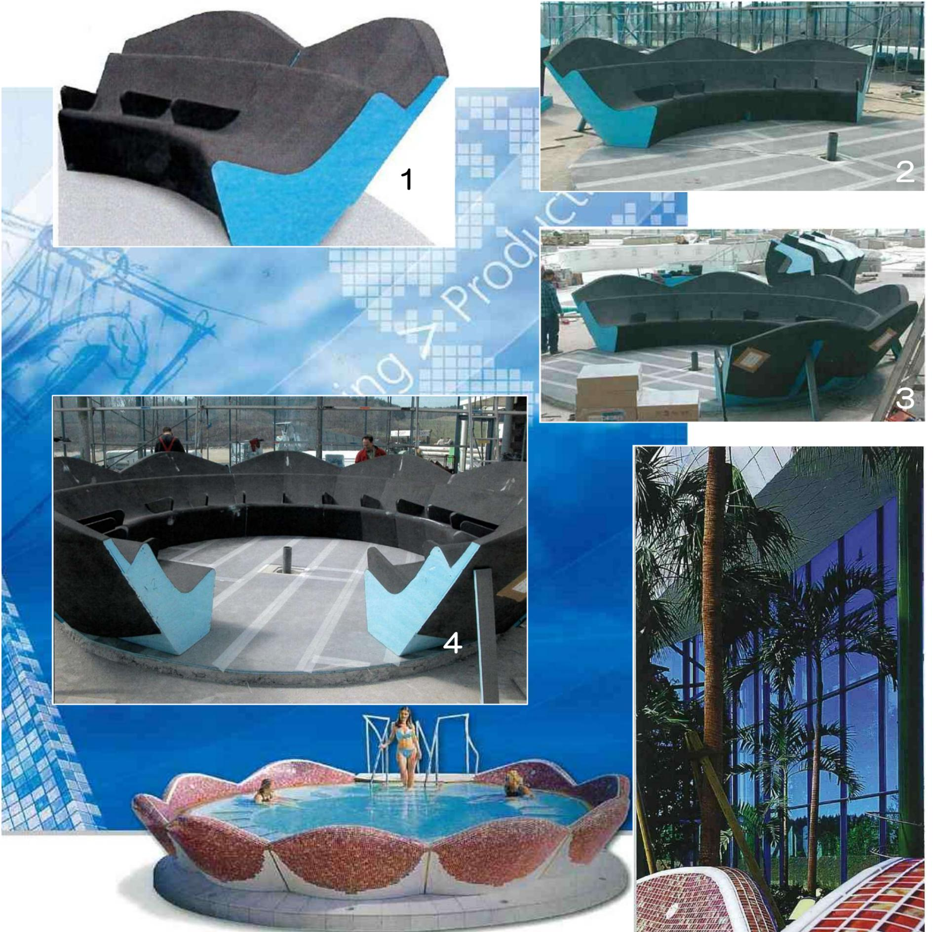
1. 2個のセクションを専用接着材（wedi 610）で接着しています。
