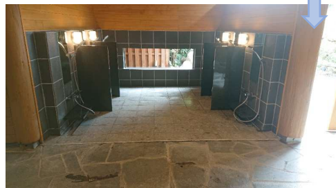
女子洗い場 石工事完了
