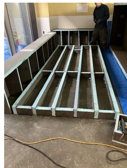
設置下地／根太の施工
