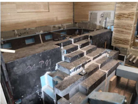
バス及びステップ下地にwediboardを使用
