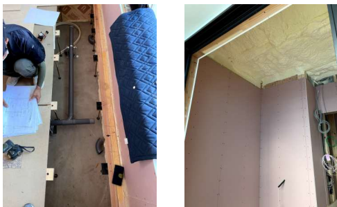
壁面にニッチカウンターの設置作業 ニッチカウンターは工場で成形済
