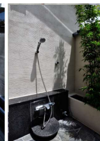
石工事の完了
