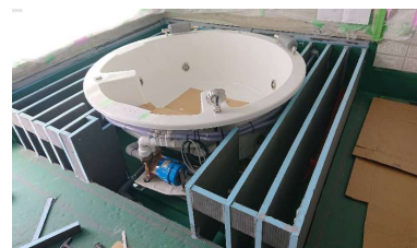
タブデッキの 根太設置
