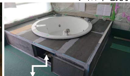
手前はバブル装置の点検口
