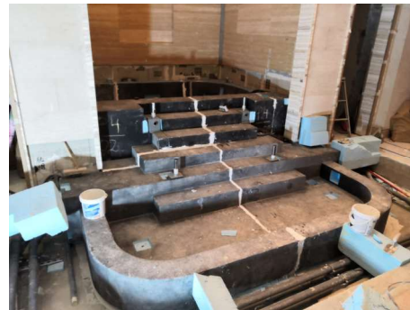
バス及びステップ下地にwediboardを使用
