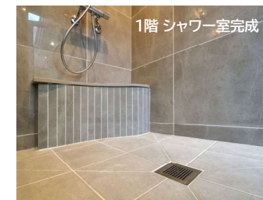
床防水下地・排水口部もウェディで施工
