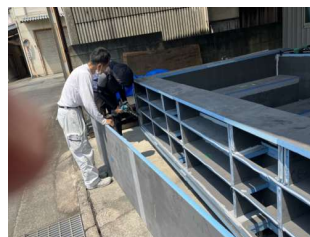
長側面カバー取り付け
