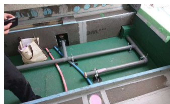
洗い場排水ユニット設置 バスタブ排水の配管工事
