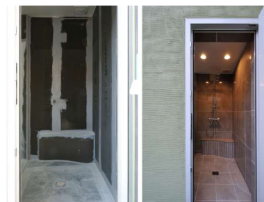
1階 屋内にもシャワー室を設置
