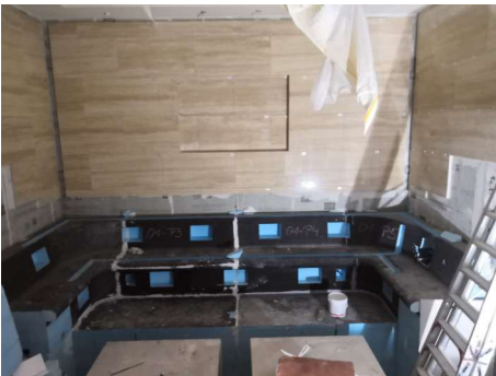
バス及びステップ下地にwediboardを使用
