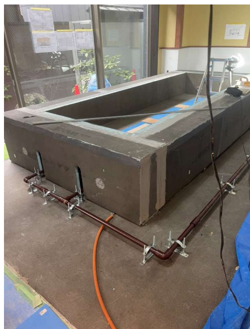
厚み100mm wedi board 使用 (外寸:1,550×3,850×550mm)
