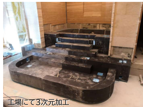
バス及びステップ下地にwediboardを使用
