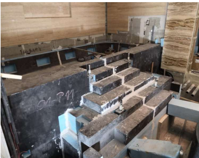
バス及びステップ下地にwediboardを使用
