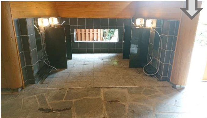
女子洗い場 石工事完了
