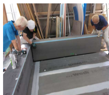
側面ブロックの固定
