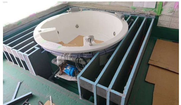
タブデッキの根太設置
