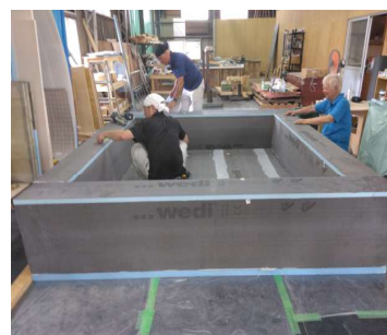
4側面ブロックの固定
