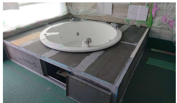
タイル下地完了
