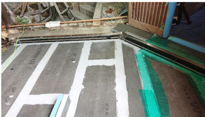
入口部のウエディボード貼りこみ ∧の字型の排水路は角度を合わせた 排水溝を工場で製作 レベルを合わせて現場で固定しました
