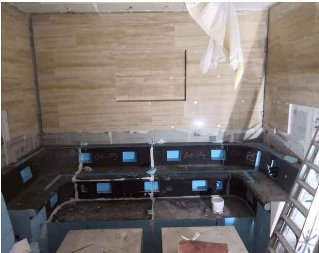
バス及びステップ下地にwediboardを使用
