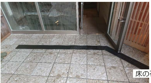
入口部のウェディボード貼りこみ ∧の字型の排水路は角度を合わせた 排水溝を工場で製作 レベルを合わせて現場で固定しました。
