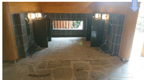
女子洗い場 石工事完了
